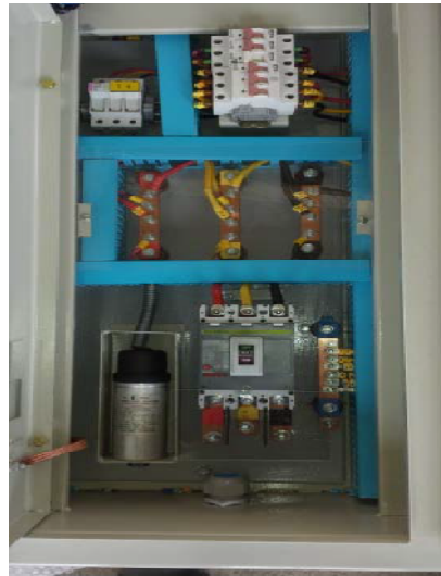
شکل (2): نمایی از بخش ورودی تابلو (نیازی به نصب خازن نیست)
