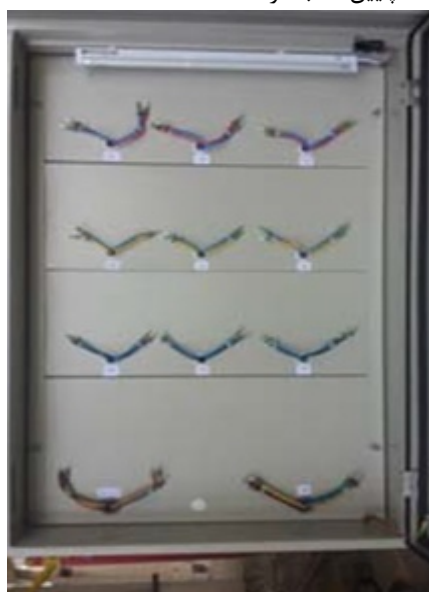
شکل (6): نمای صفحه نگهدارنده کنتورها پس از سیم‌کشی (از ریسه به جای مهتابی استفاده شود)
