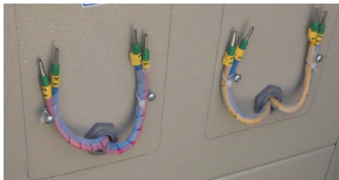
شکل (5): محل و نحوه خروج سیم‌ها از صفحه نگهدارنده
